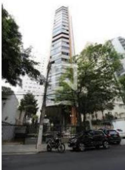
Condomínio Parque de Laje 071-20250314JR
