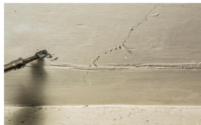
Injeção e avanço do produto
