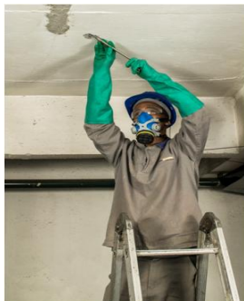
Instalação bicos injetores
