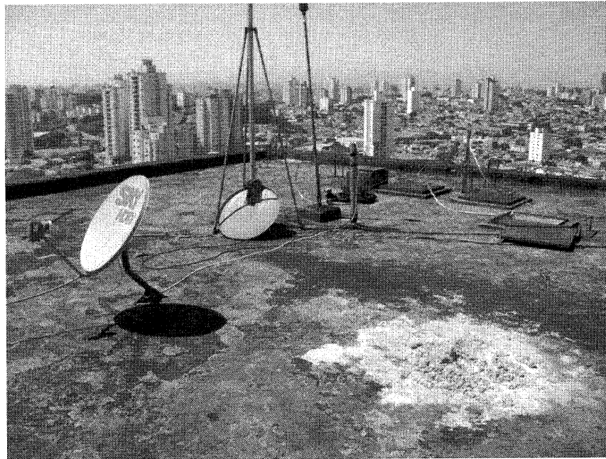
Figura 1 – local para a colocação dos equipamentos
