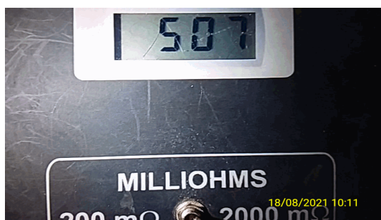
Foto - Medição continuidade pilar 04
