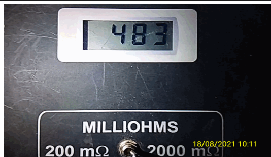
Foto - Medição continuidade pilar 01
