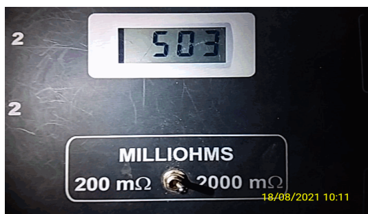
Foto - Medição continuidade pilar 03
