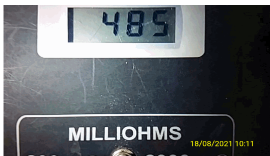
Foto - Medição continuidade pilar 02
