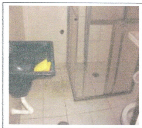
Foto 14 – Banheiro c/Bos e Tanque
