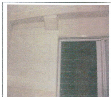
Foto 18 – Banheiro Porta Sanfonata
